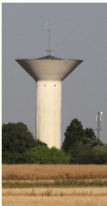
Un nouveau château d'eau fut construit sur le site de la Grenouillère. L'alimentation en eau du village se fait à partir de deux puits situés au sud-est de Corbreuse aux lieux-dits de la Grenouillère et des Yèbles. L'eau est pompée puis envoyée dans le château d'eau pour alimenter la totalité du village.
